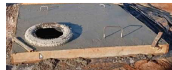
FIGURA 5: EXEMPLO DE FABRICAÇÃO DA TAMPA COM INSPEÇÃO E ALÇAS DE 3/8" PARA IÇAMENTO.
